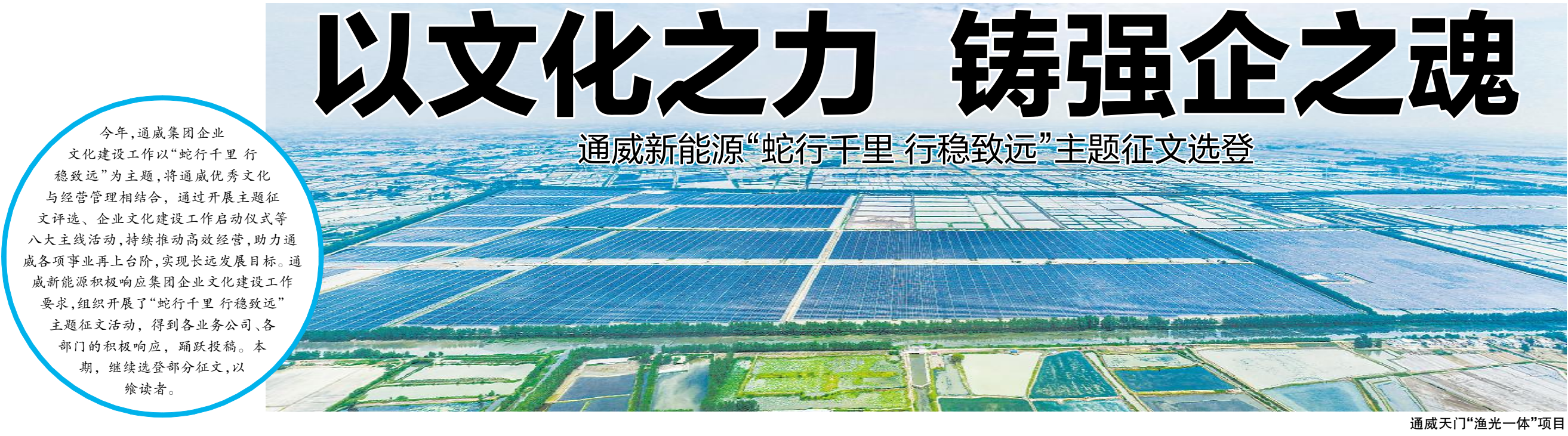
通威天门“渔光一体”项目
