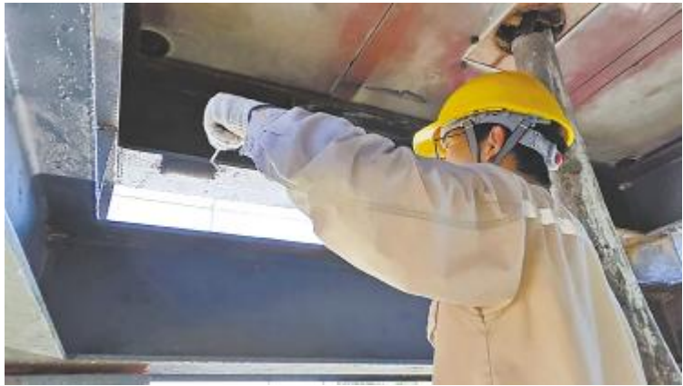
一线运维人员紧固螺栓
